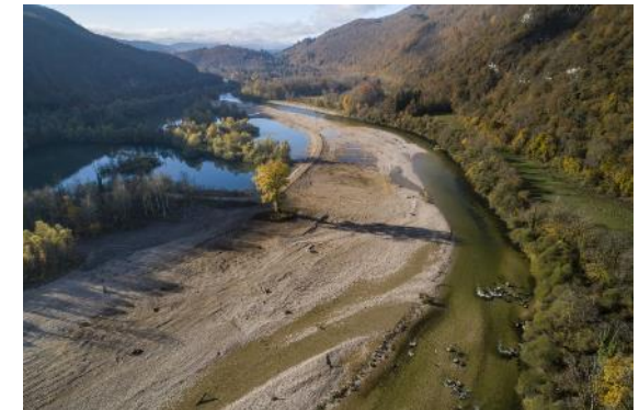
Le site à la fin des travaux, décembre 2021
