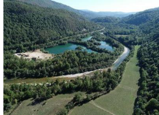
Avant les travaux, début 2021
