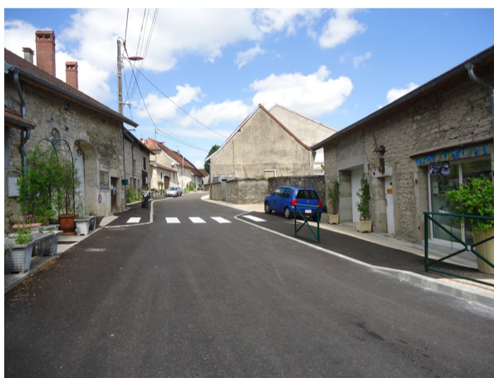
Aménagement rue de l'église à Onoz
