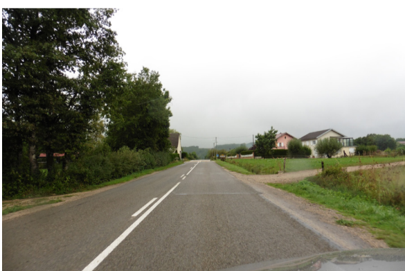
Entre Moutonne et Orgelet, piétons et cyclistes sont en difficulté.
