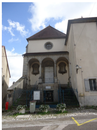
Médiathèque à Orgelet
