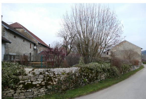
Chavéria - muret de pierres sèches à couronnement horizontal
