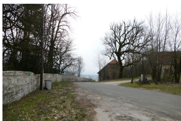
Merona : mur limite en pierres jointoyées le long du château
