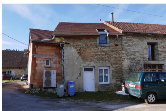
Arthenas : percements en toiture, extension, pose de PAC en façade.
