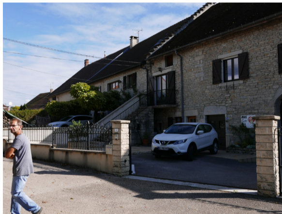
Nogna -Muret béton et barreaudage métal
