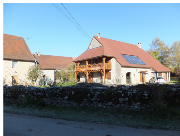
Poids-de-Fiole : percement d'ouvertures et création d'une galerie bois en pignon.
