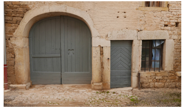
Succession des ouvertures dans une façade à Nancuisse : distinction évidente entre la grange et l'habitation
