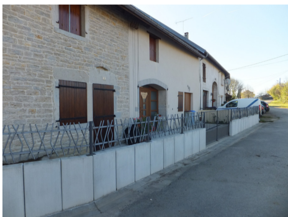
Poids-de-Fiole : muret en modules de béton préfabriqué et barreaudage métal
