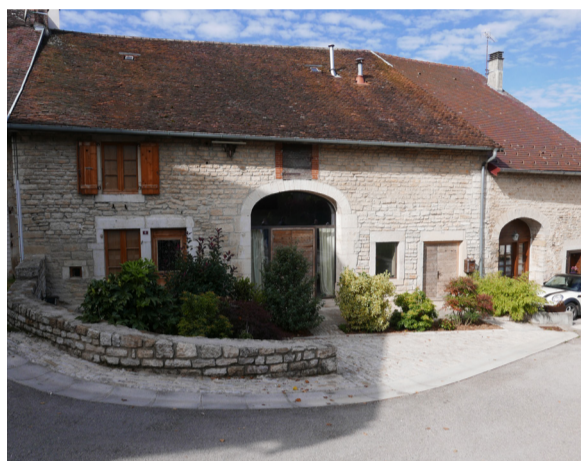
Saint-Maur - adaptation de la porte de Grange
