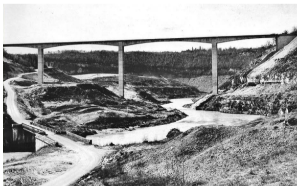
Ancien et nouveau pont de la Pyle - association asphor
