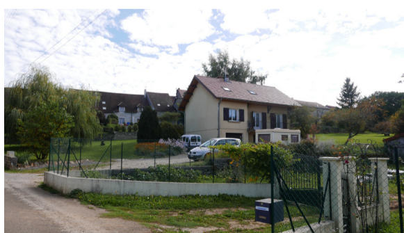
Construction d'une dent creuse à Saint-Maur
