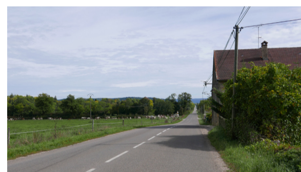
La RD 2 route digue du bassin entre Beffia et Orgelet
