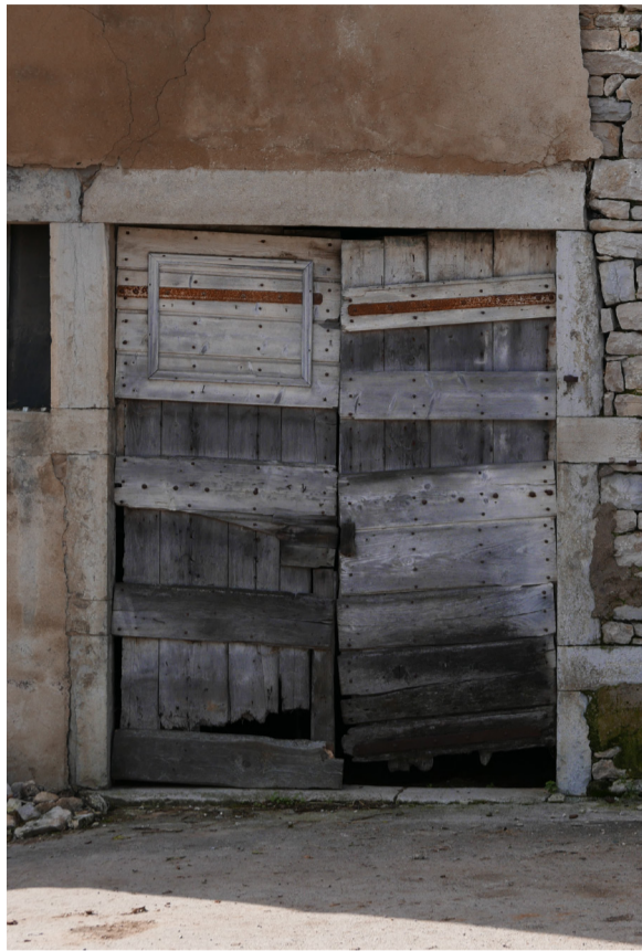
Reste d'un enduit ocré à Nogna. La pose à fleur de pierre de manière à dégager les encadrement rectangulaires est visible en haut de la porte de grange
