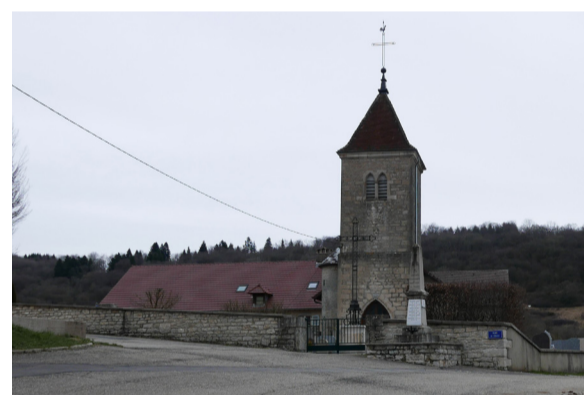
Rothonay : mur d'enceinte de l'Eglise
