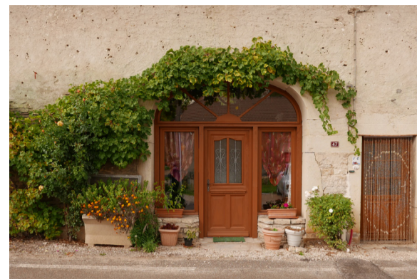
Nancuisse, transformation d'une porte de Grange
