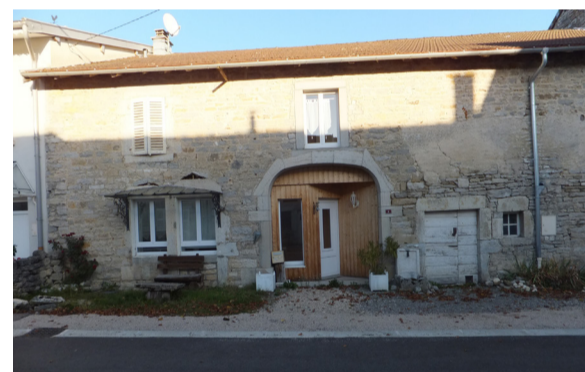
Onoz - pose d'éléments de menuiserie préfabriqués
