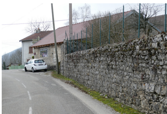
Onoz- mur de soutènement en pierres partiellement jointoyées
