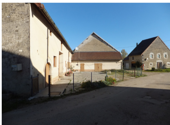
Poids-de-Fiole : muret en simple grillage
