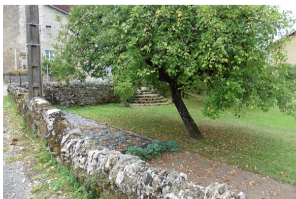
Mur en pierre à Cressia
