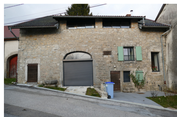
La Tour-du-Meix : modification de la toiture, percements en façade, transformation de porte de grange, pose de volet roulant
