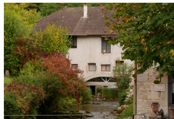
Nancuisse : construction d'un plancher dans passage voûté (moulin) et création d'ouvertures...
