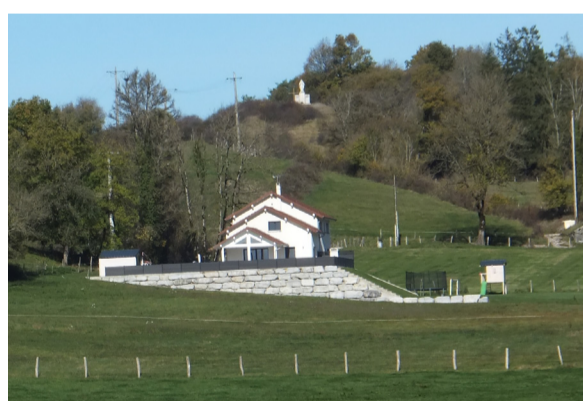
Rothonay : exemple de l'adaptation de la parcelle à l'habitat, création d'une plateforme
