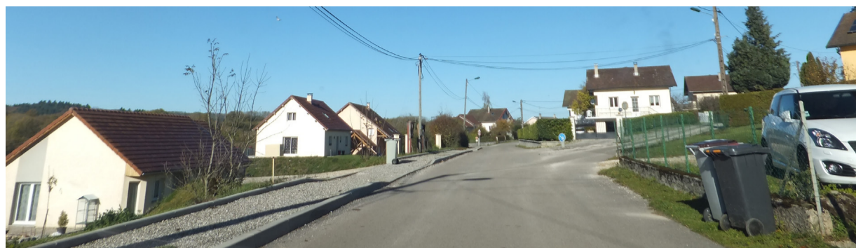
Zone pavillonnaire de Poids-de-Fiole, composée en poche autour d'une rue qui forme une boucle
