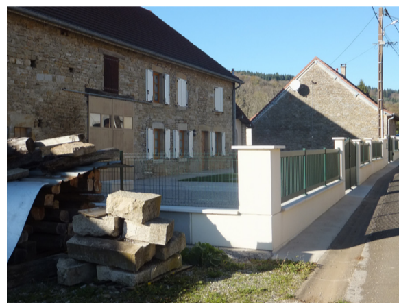
Nogna -Muret béton et barreaudage métal
